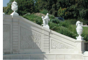
Flankenwand nach Fertigstellung
