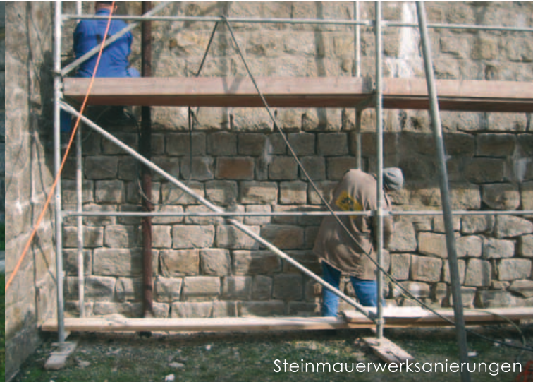
ausgebrochenes Steinmauerwerk
